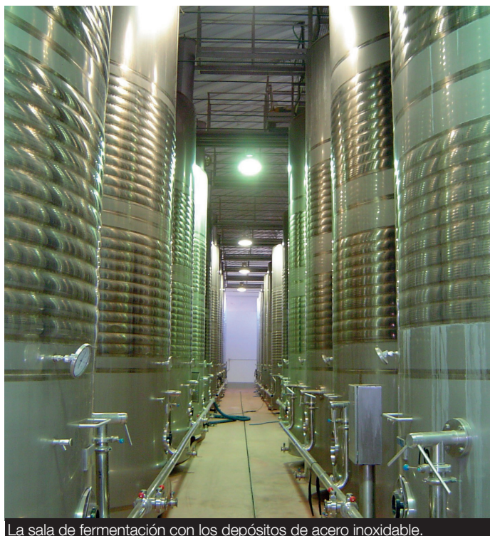
La sala de fermentación con los depósitos de acero inoxidable.
